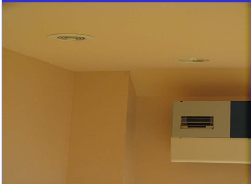
ルーム内 天井空気吹出し口
