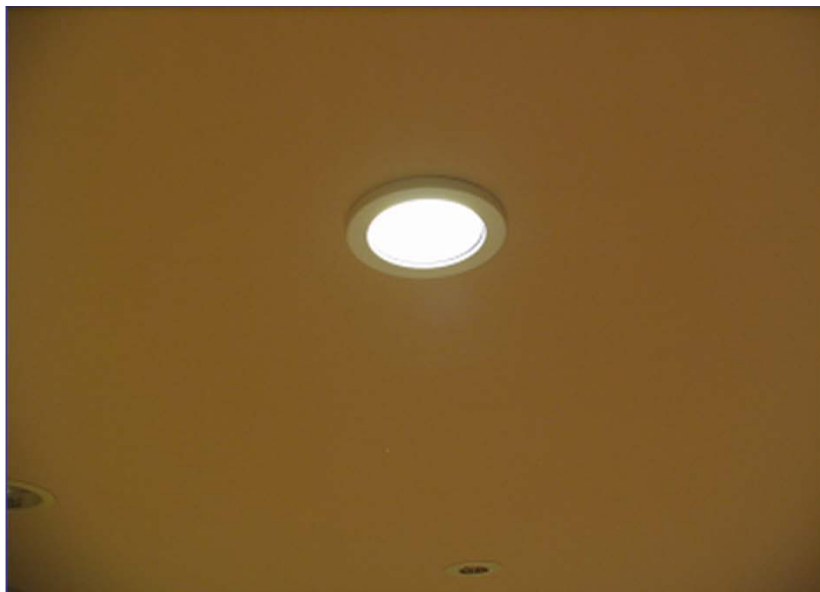
ルーム内 天井太陽光照射口
