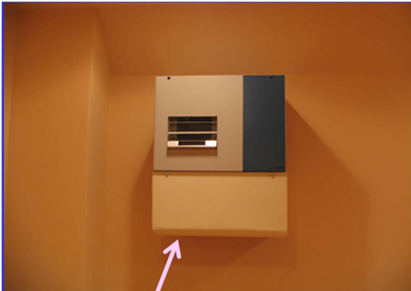
ルーム内 加湿装置吹き出し口
