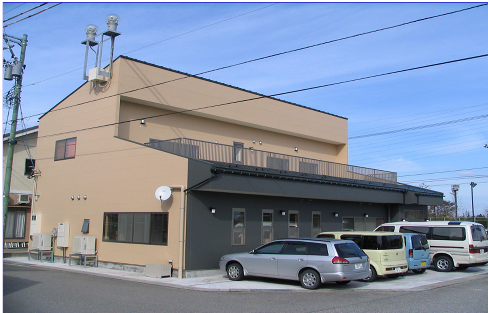
治療型温熱ルーム建屋全景
